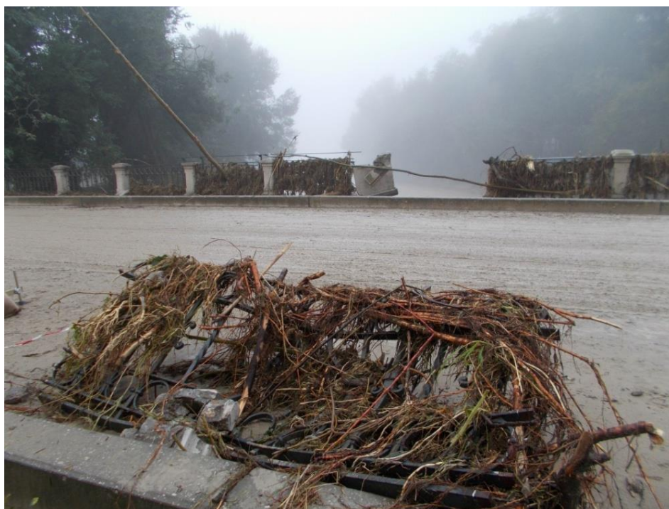
Figura 3-5 – Piena del torrente Baganza del 13-14 ottobre 2014, il 14/10/2014 alle ore 8.44 a Ponte Nuovo, con evidenti segni di sormonto (foto Marco Belicchi).
