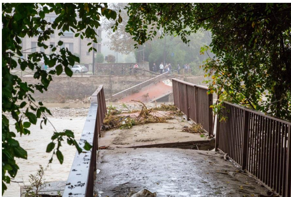
Figura 3-6 – Crollo del ponte ciclopeditale “della Navetta” durante la piena del torrente Baganza il 13/10/2014.
